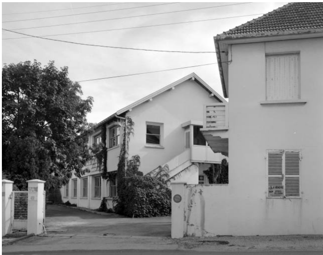
Entrée de l'usine, bureau et réfectoire.
