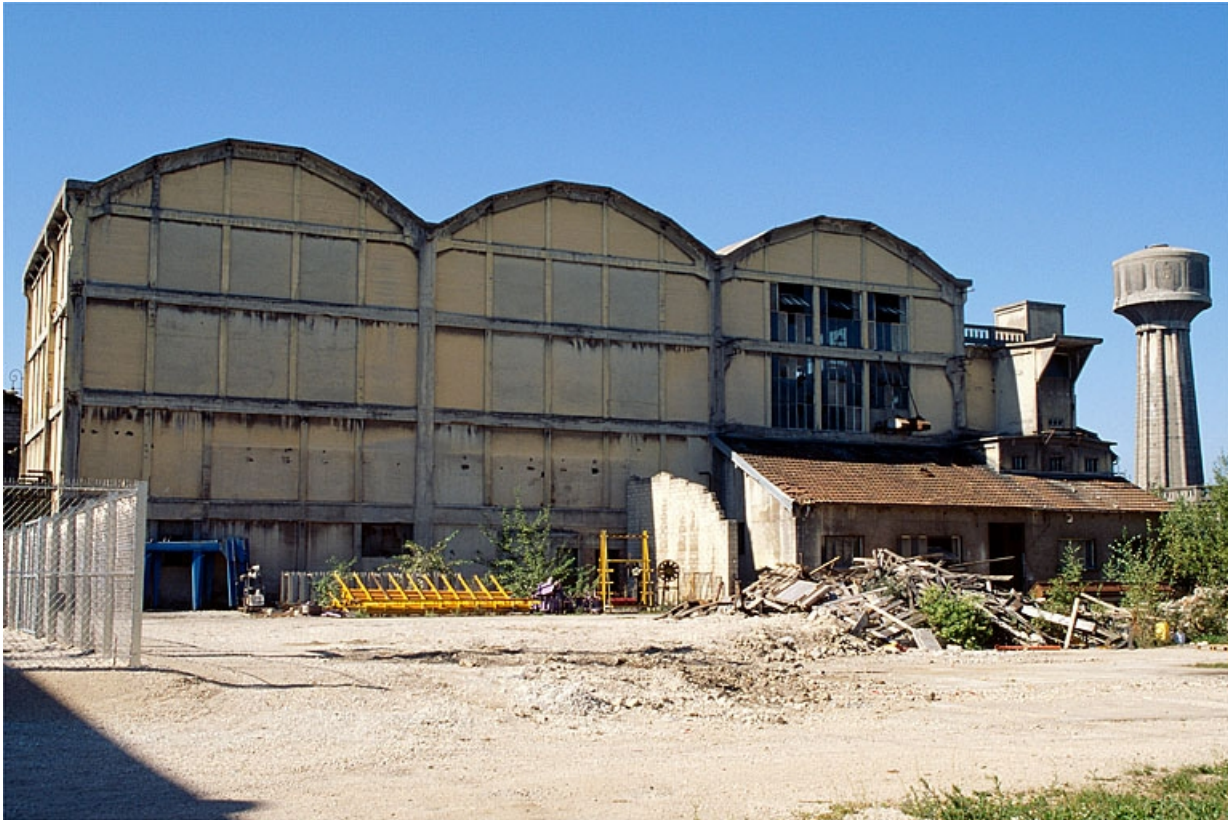
La centrale thermique depuis l'est.
