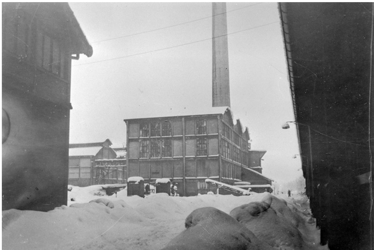
La centrale thermique depuis le sud-est.
