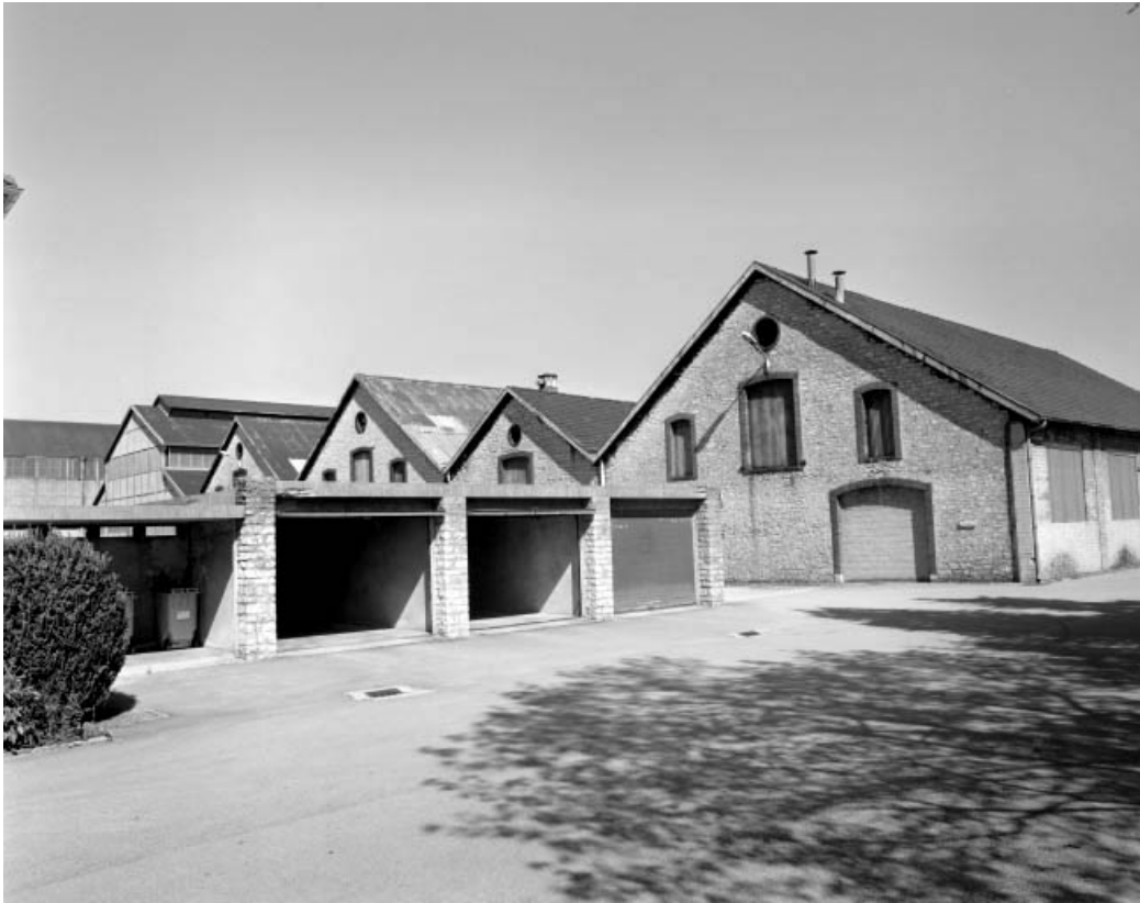
Pignons des ateliers de l'ancienne forge.
