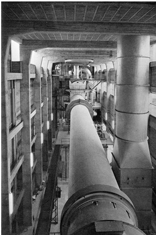
Vue d'ensemble du four rotatif.
