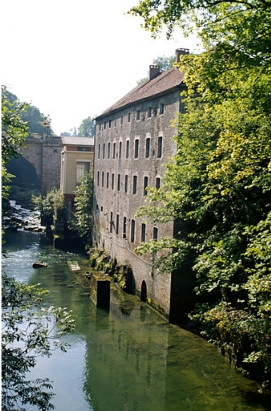
Elévation de l'atelier de fabrication depuis l'aval.
