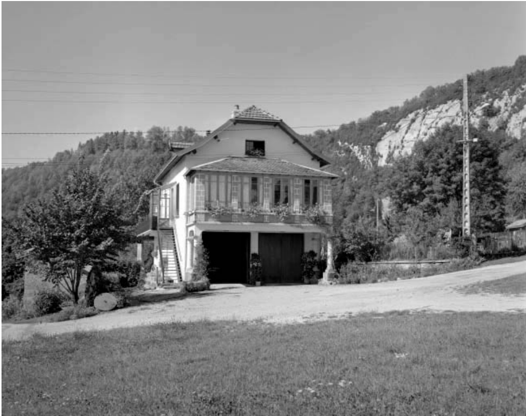
Logement patronal depuis l'est.
