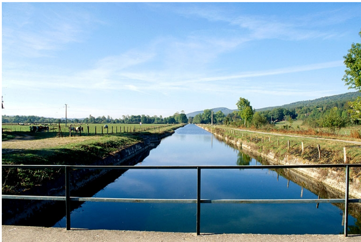
Le canal d'amenée depuis la prise d'eau.
