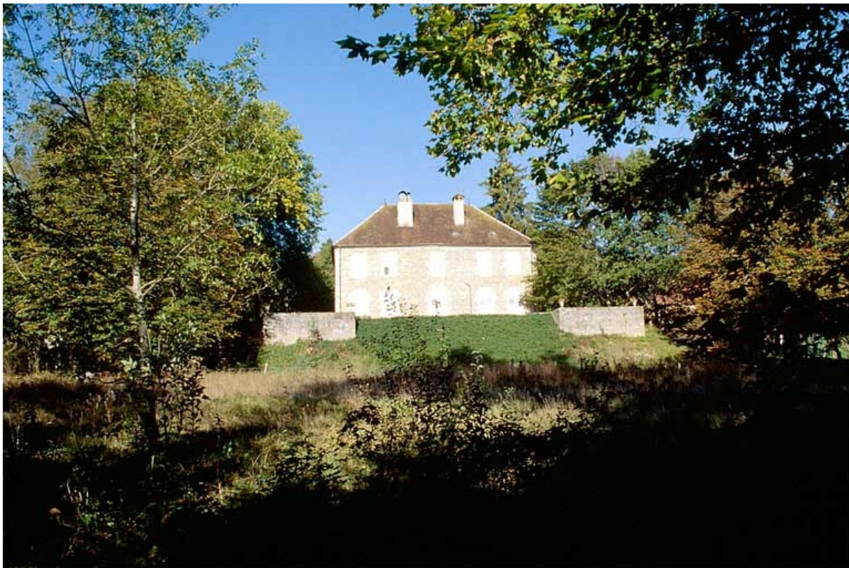
Façade postérieure du logement patronal.
