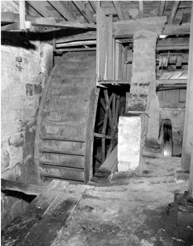
Bâtiment d'eau : la roue hydraulique.
