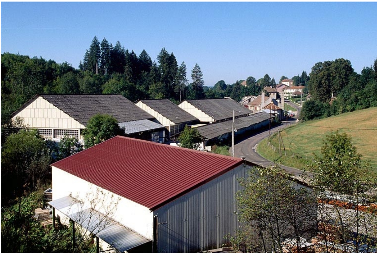
Vue d'ensemble depuis la voie ferrée.
