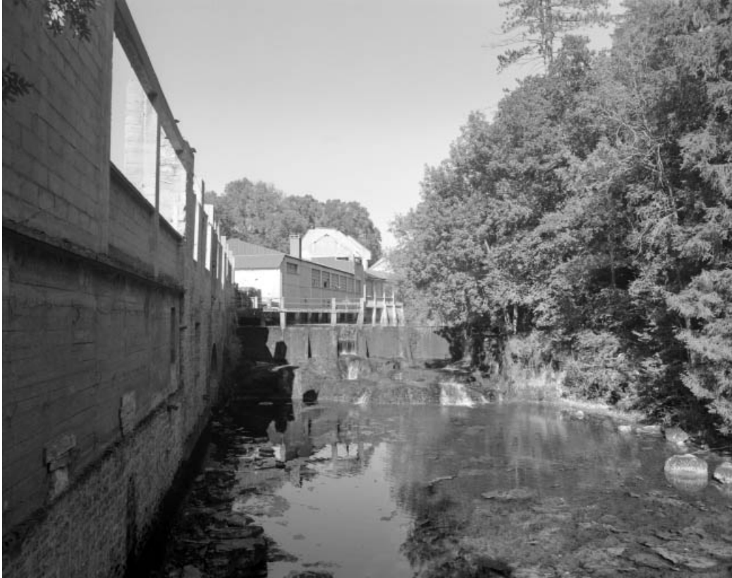
Façades de l'usine sur l'Angillon et barrage.
