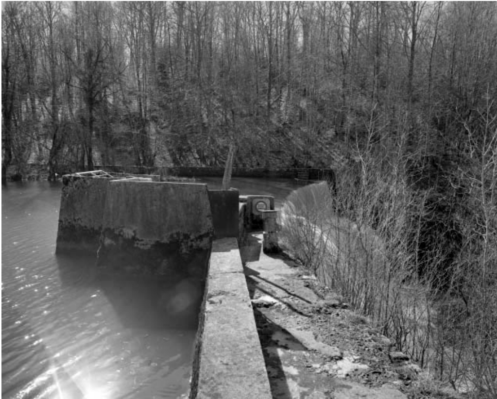
Tour de prise d'eau et barrage.
