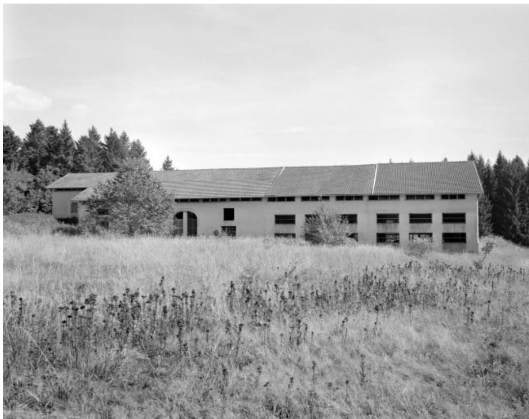
Façade postérieure du séchoir.
