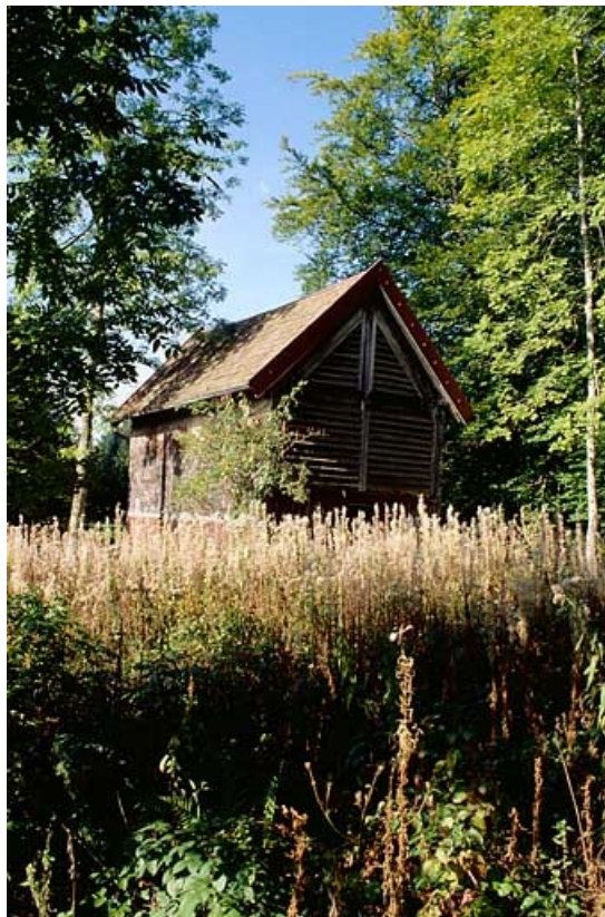
Vue de trois quarts du hangar séchoir.
