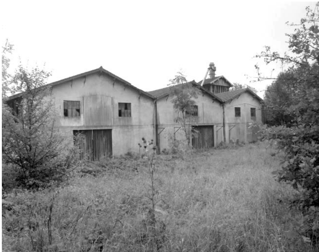
Façade postérieure de l'atelier de fabrication.
