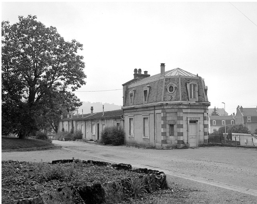
Chai et logement ouest.
