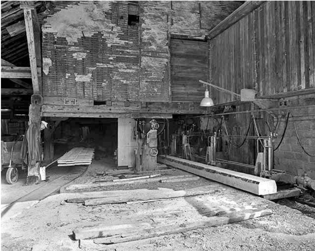
Intérieur de l'atelier de sciage.
