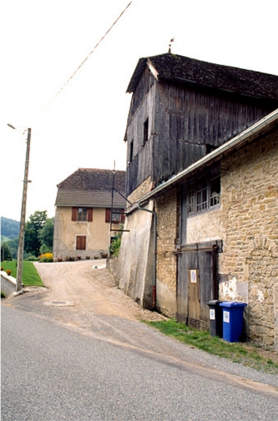
Elévation ouest de l'atelier de fabrication. La partie talutée correspond au soubassement du haut fourneau.
