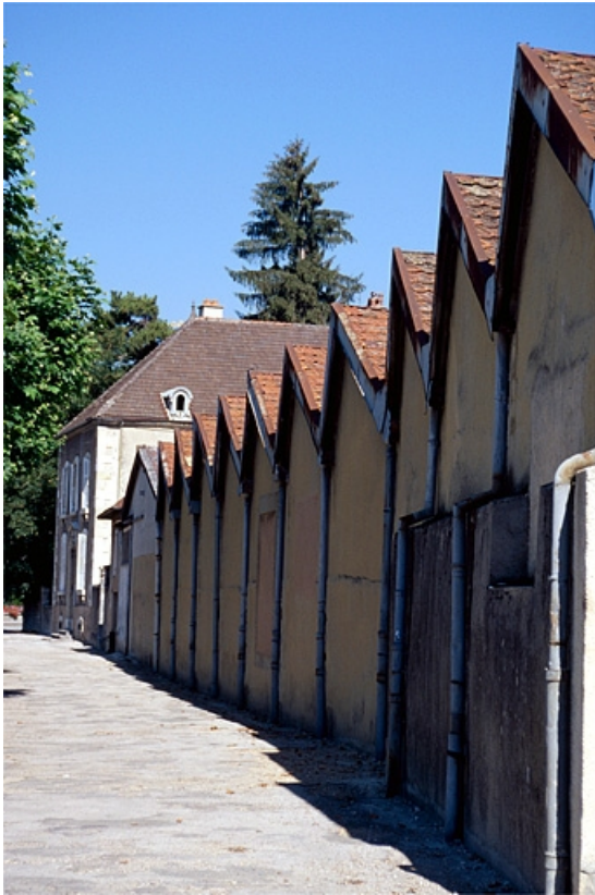
Façades sud et sheds des magasins industriels.
