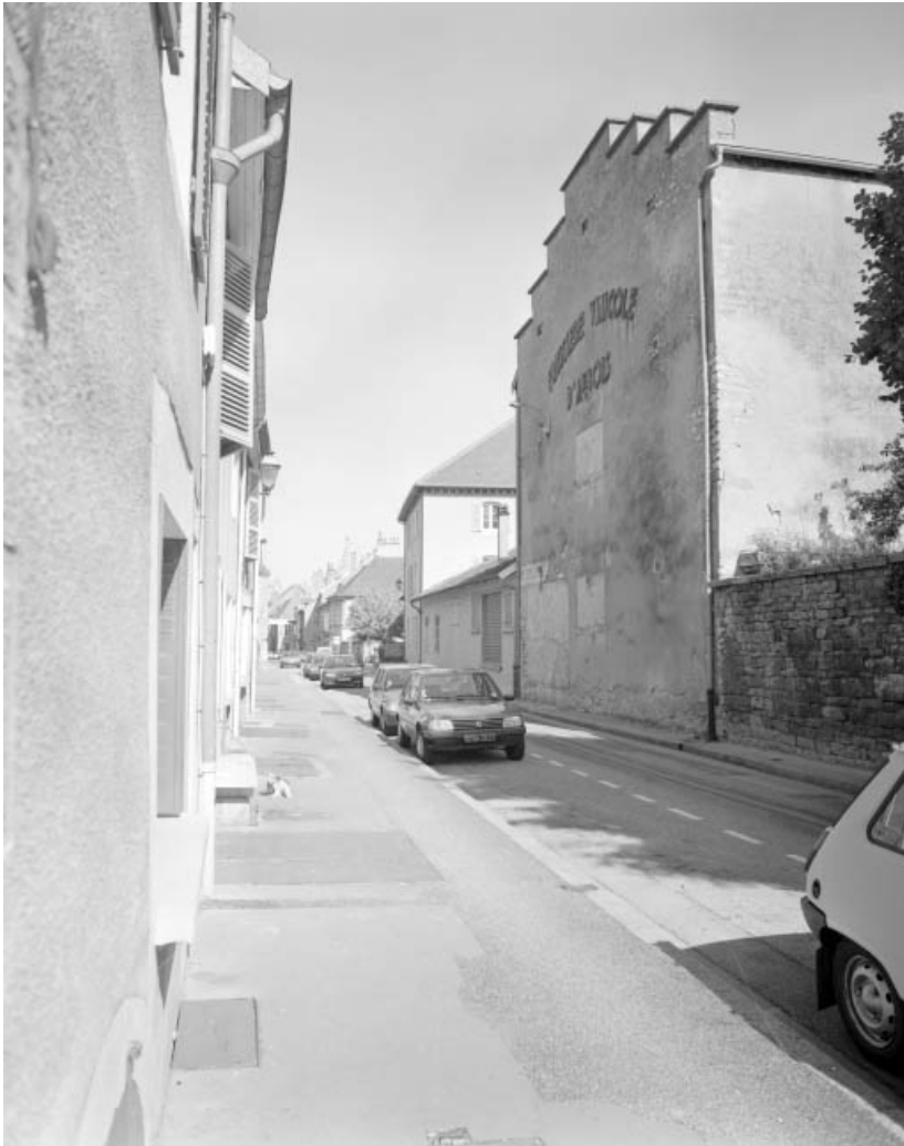
Pignon à redents d'un chai.
