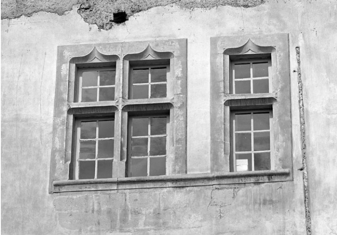
Fenêtres de l'étage de la face est.
