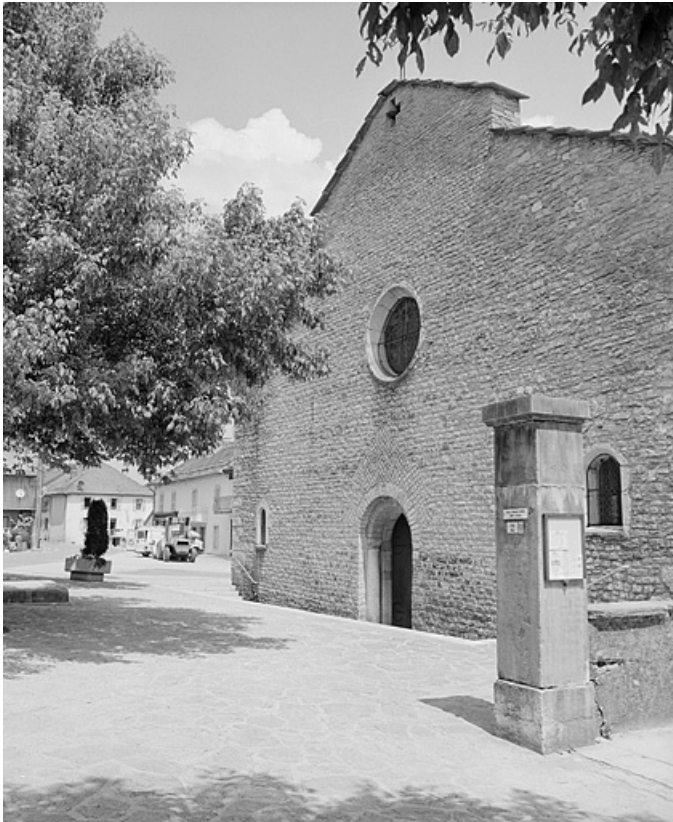
Façade ouest de l'église.
