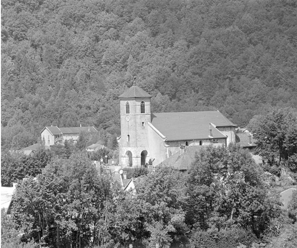
Vue de situation depuis le sud-ouest.
