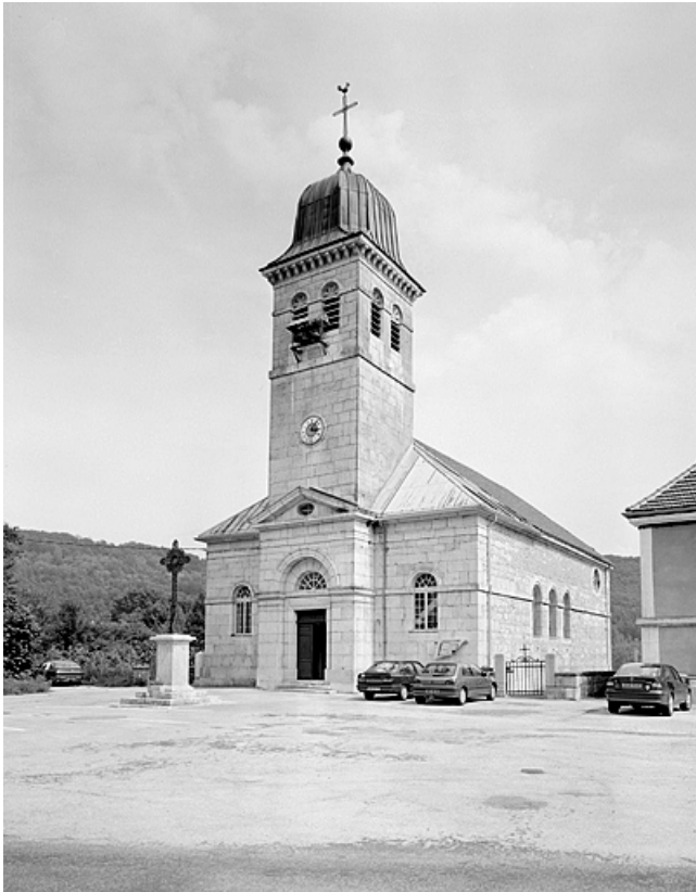
Façade antérieure et face droite.
