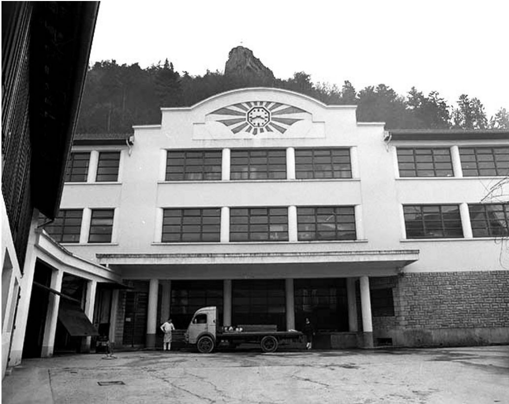
Atelier de fabrication : fronton de la façade.
