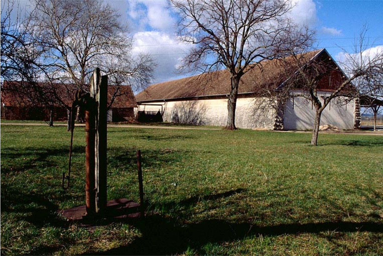
Magasin industriel vu de trois quarts arrière.
