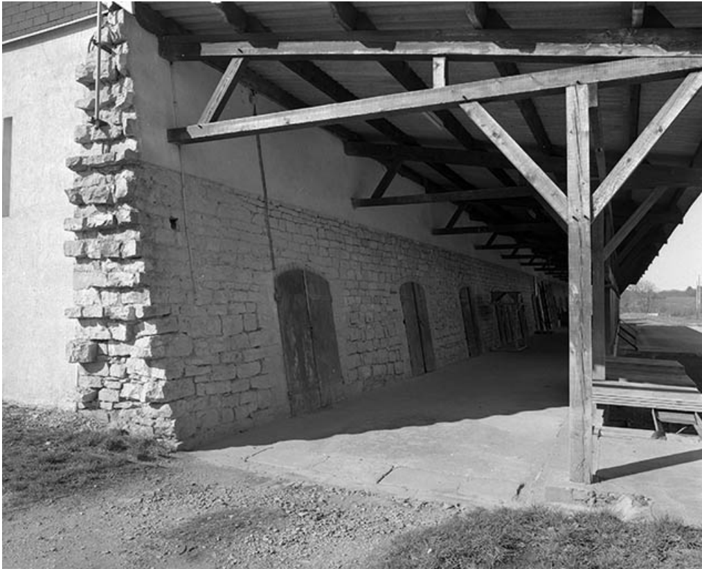
Mur nord du magasin industriel.
