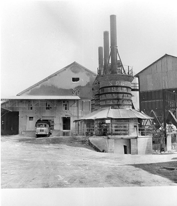
[Atelier de fabrication et fours à surcuit].
