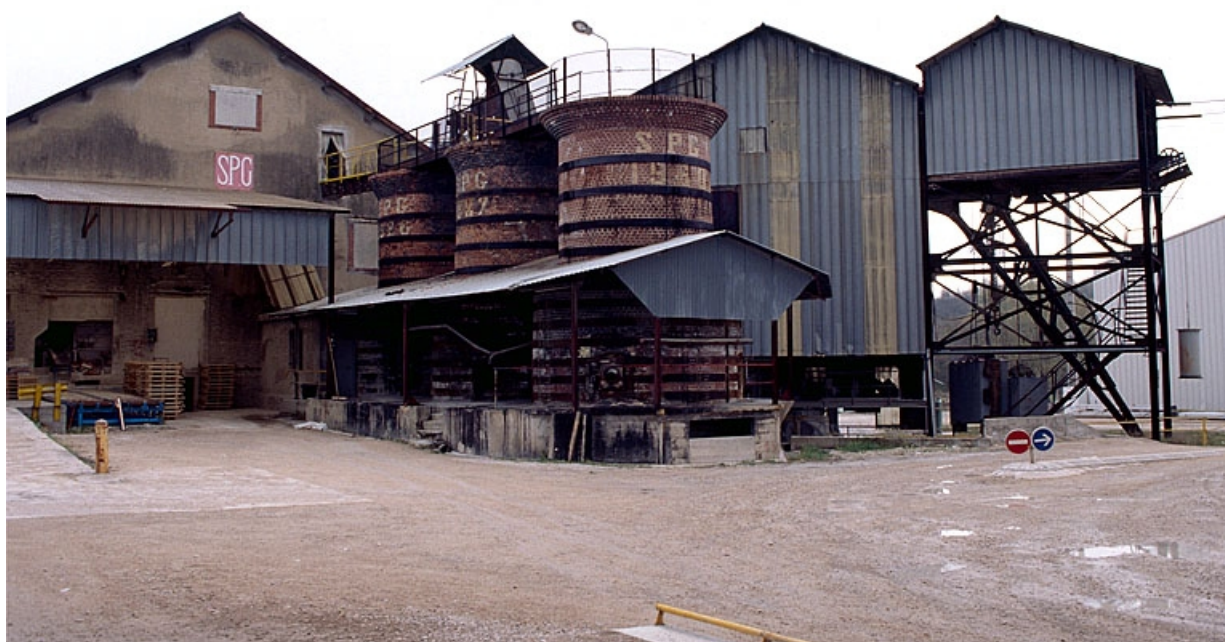
De gauche à droite : bâtiment des fours, anciens fours à surcuit, broyeur et poste de chargement.
