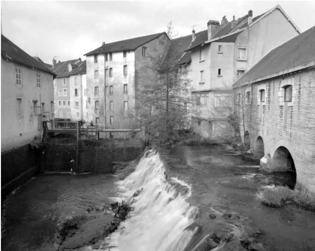
Le bassin de retenue vidé.
