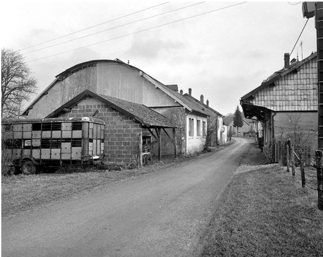
Ateliers de fabrication depuis le sud.
