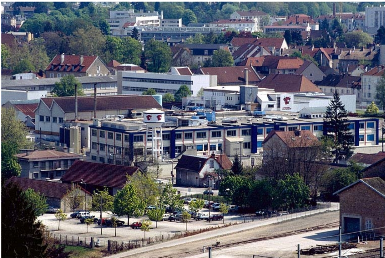
Vue d'ensemble depuis la côte de Montciel.
