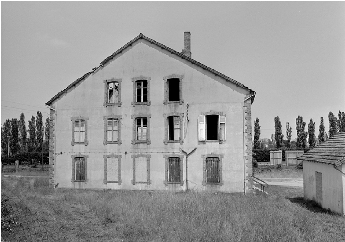
Façade postérieure du logement patronal et bureau.
