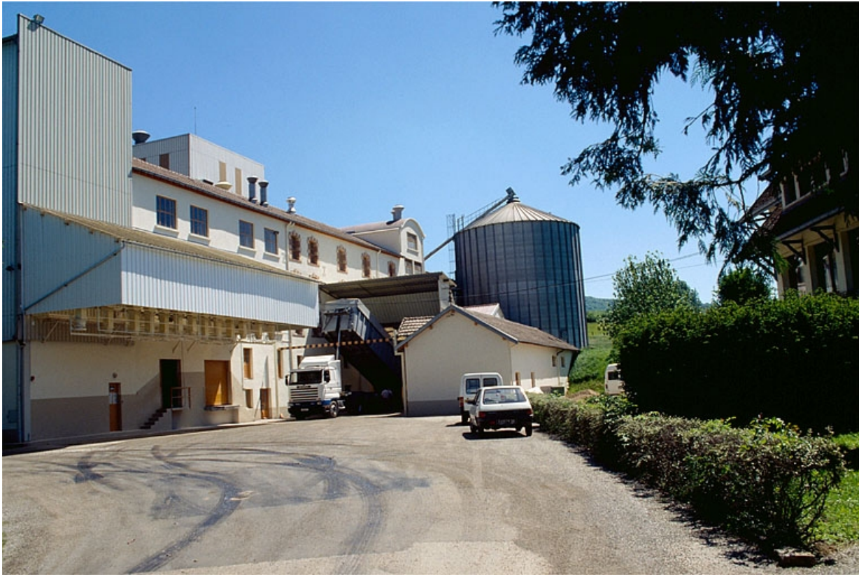
Atelier de fabrication et silos depuis l'entrée.
