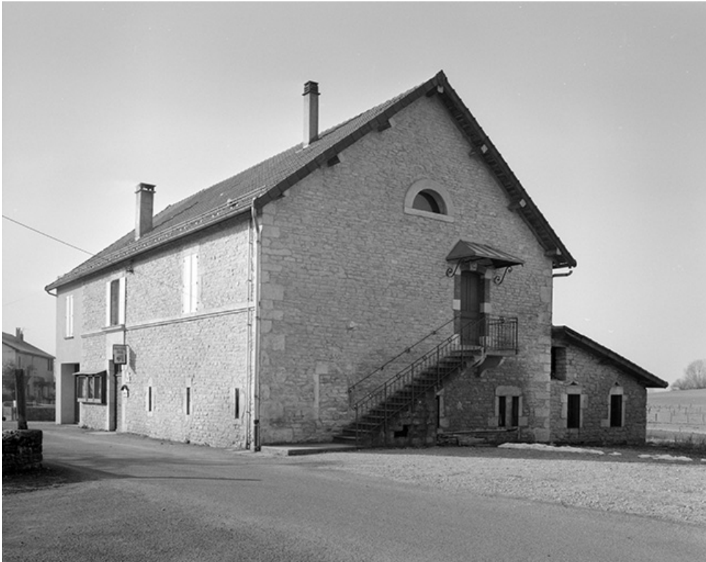
Vue depuis le nord.
