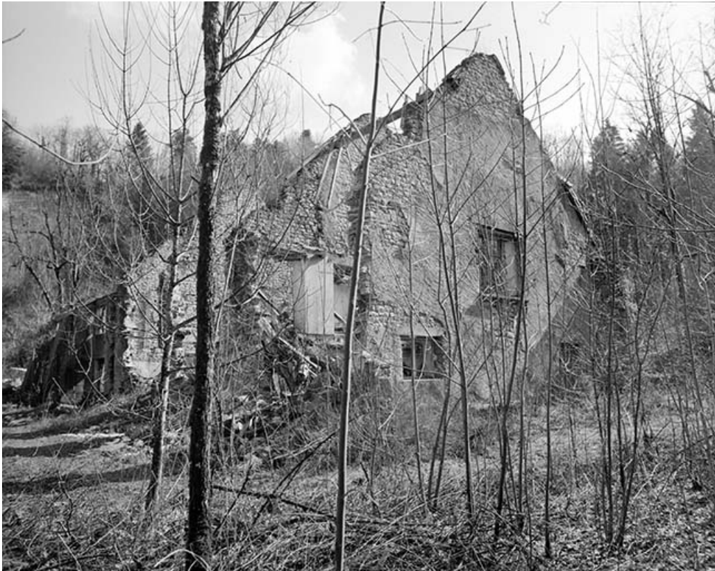
Pignon ouest du logement patronal.
