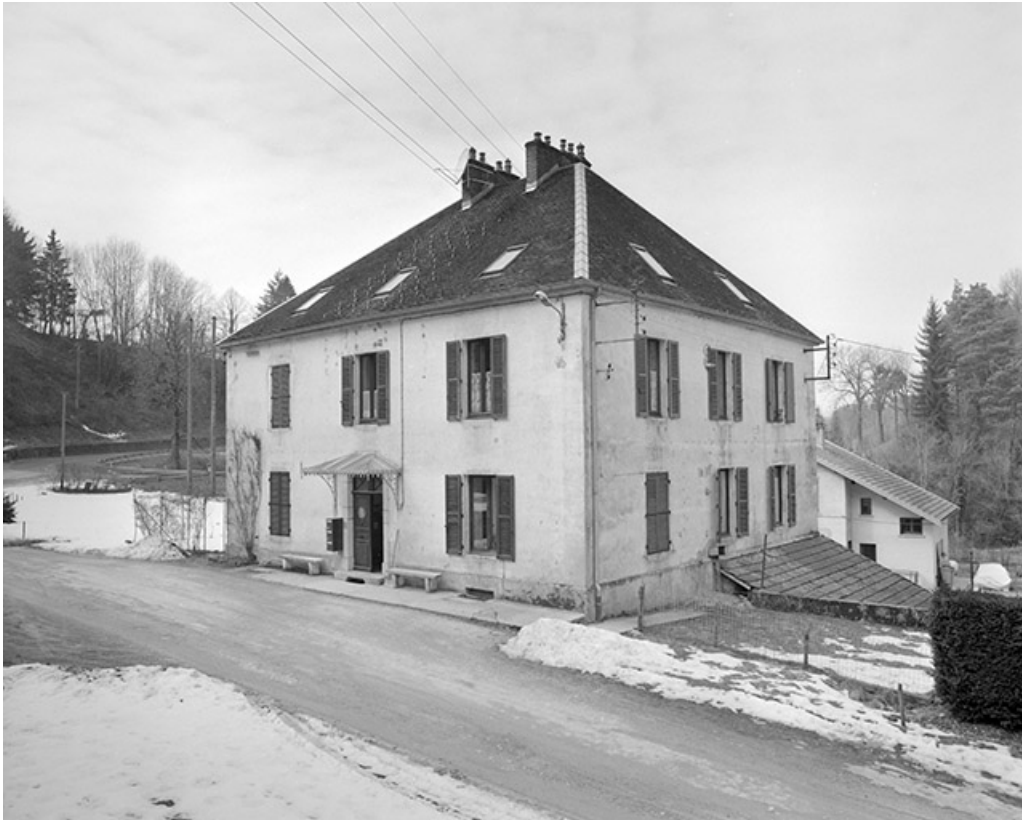
Logement patronal vu de trois quarts droit.
