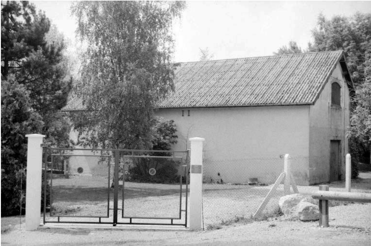
Bâtiment de prise d'eau.
