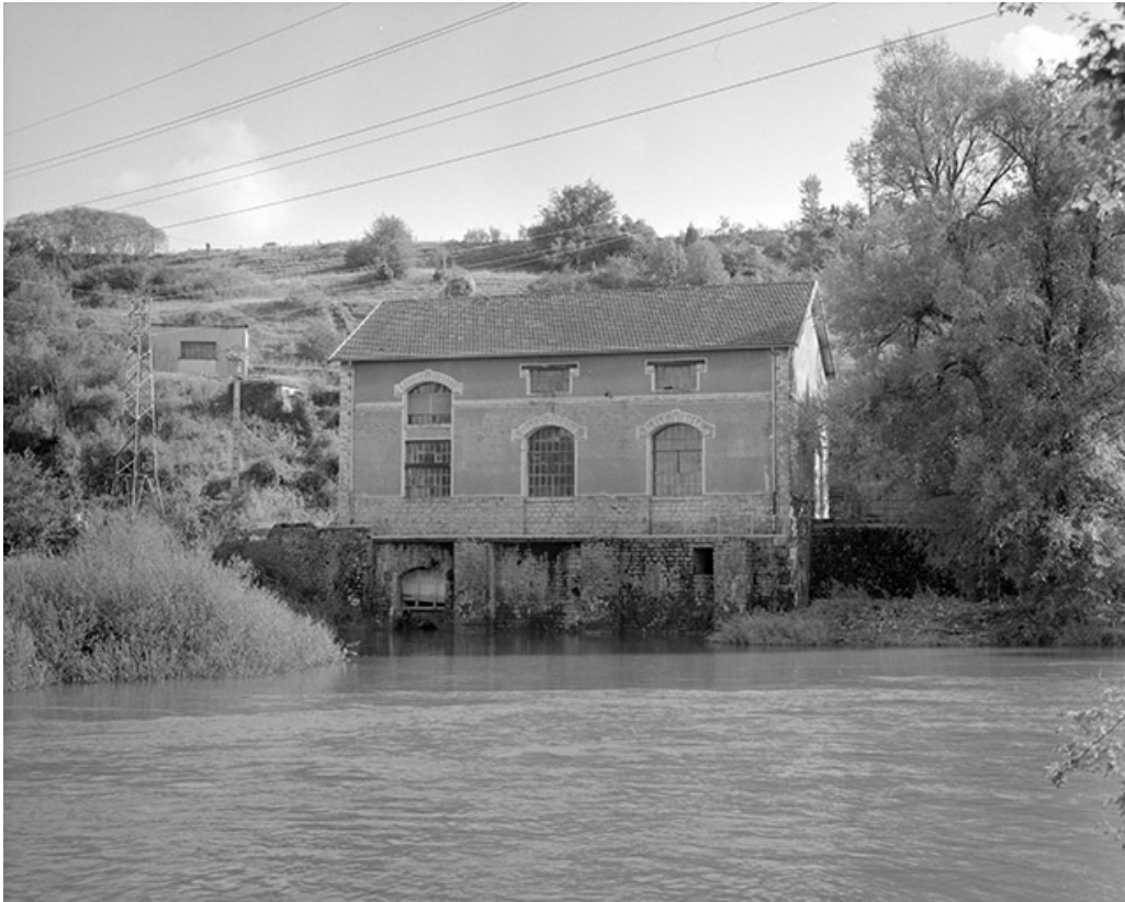
Façade postérieure de la centrale.
