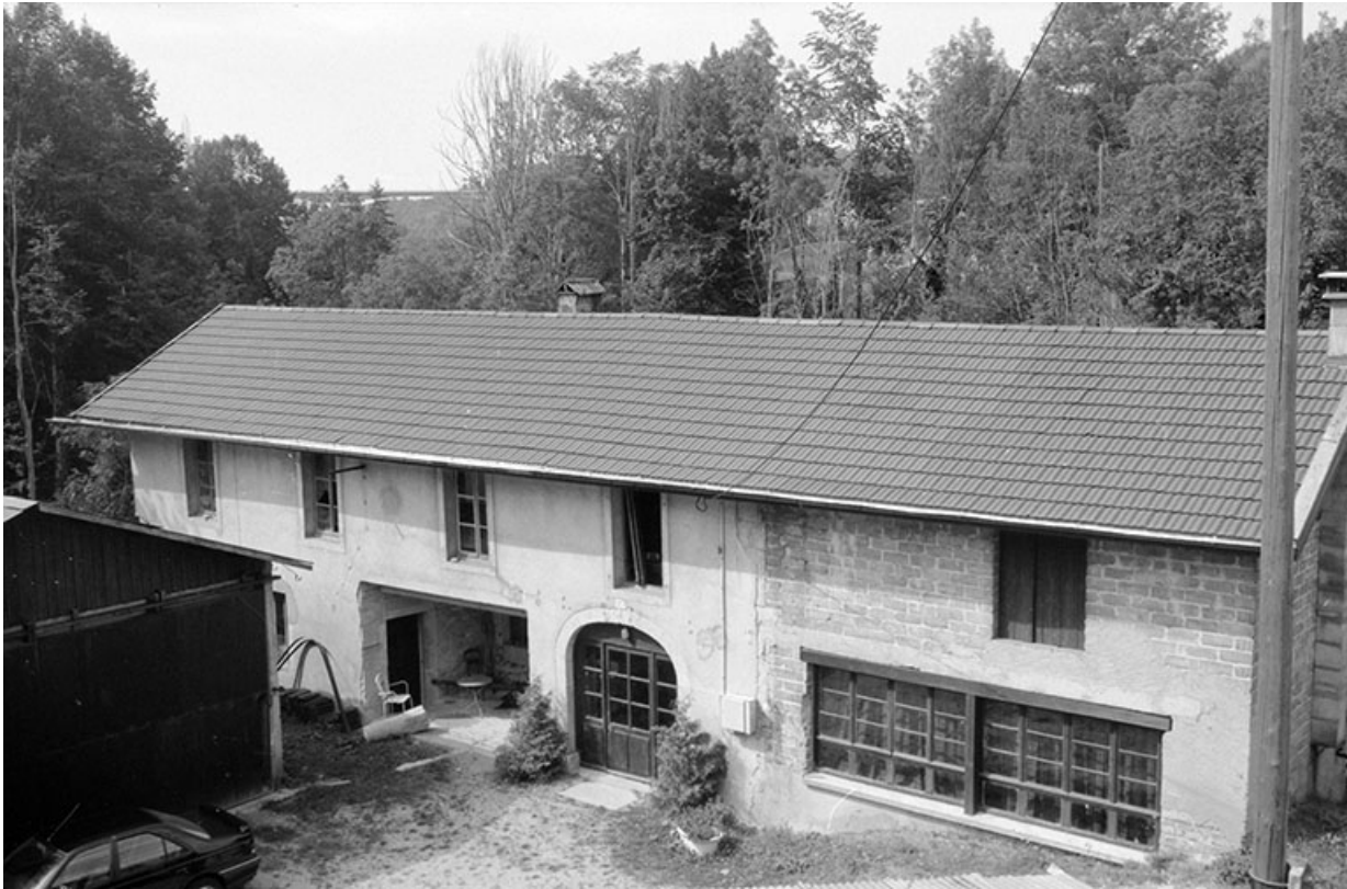
Façade antérieure des ateliers de fabrication.
