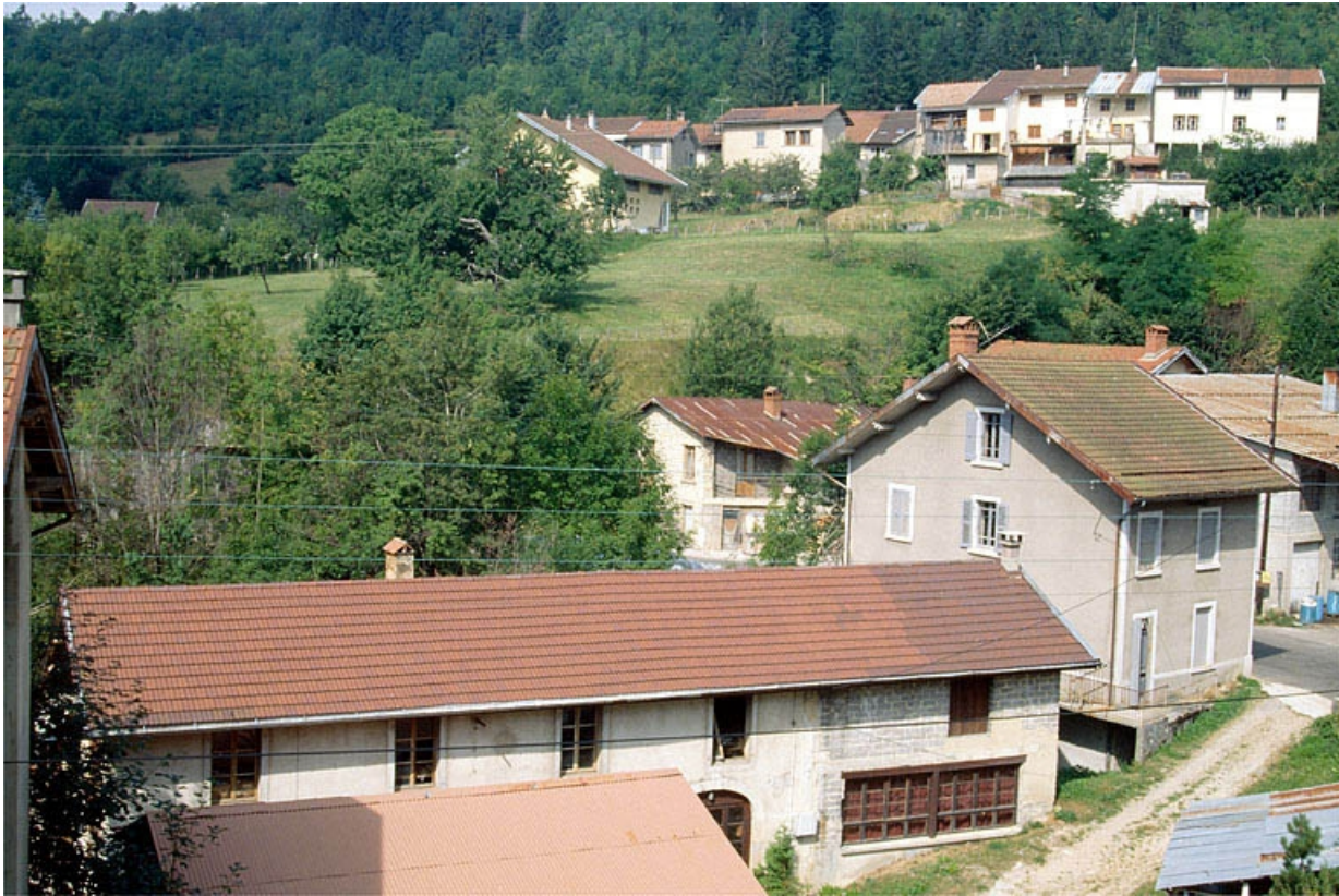
Ateliers de fabrication et logement.
