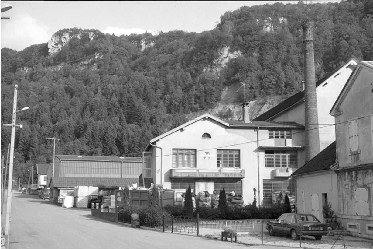
Bureau, entrepôt industriel et cheminée d'usine.
