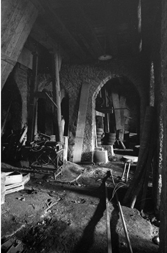
Etage de soubassement des ateliers de fabrication.
