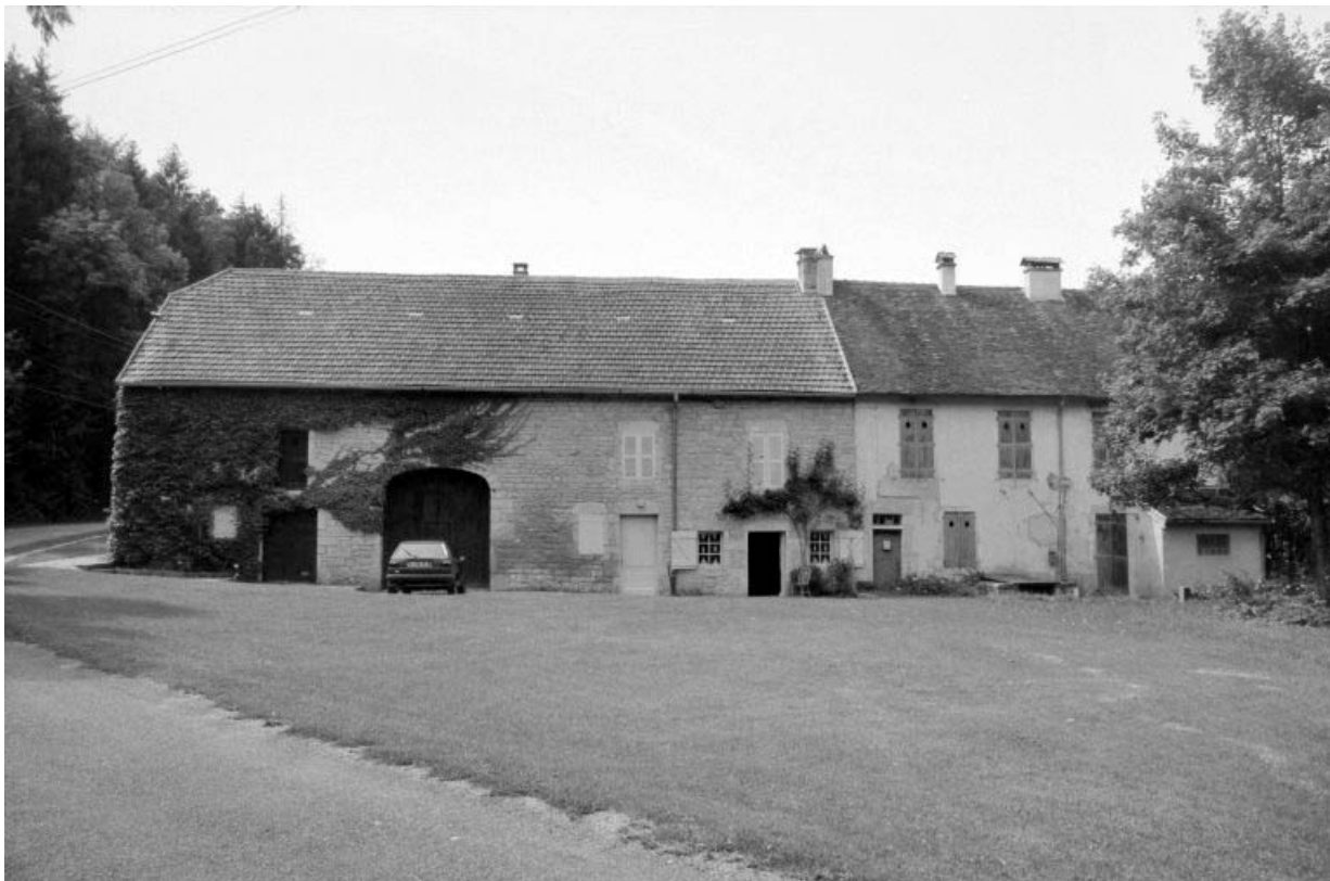
Façade postérieure du logement et de l'étable.
