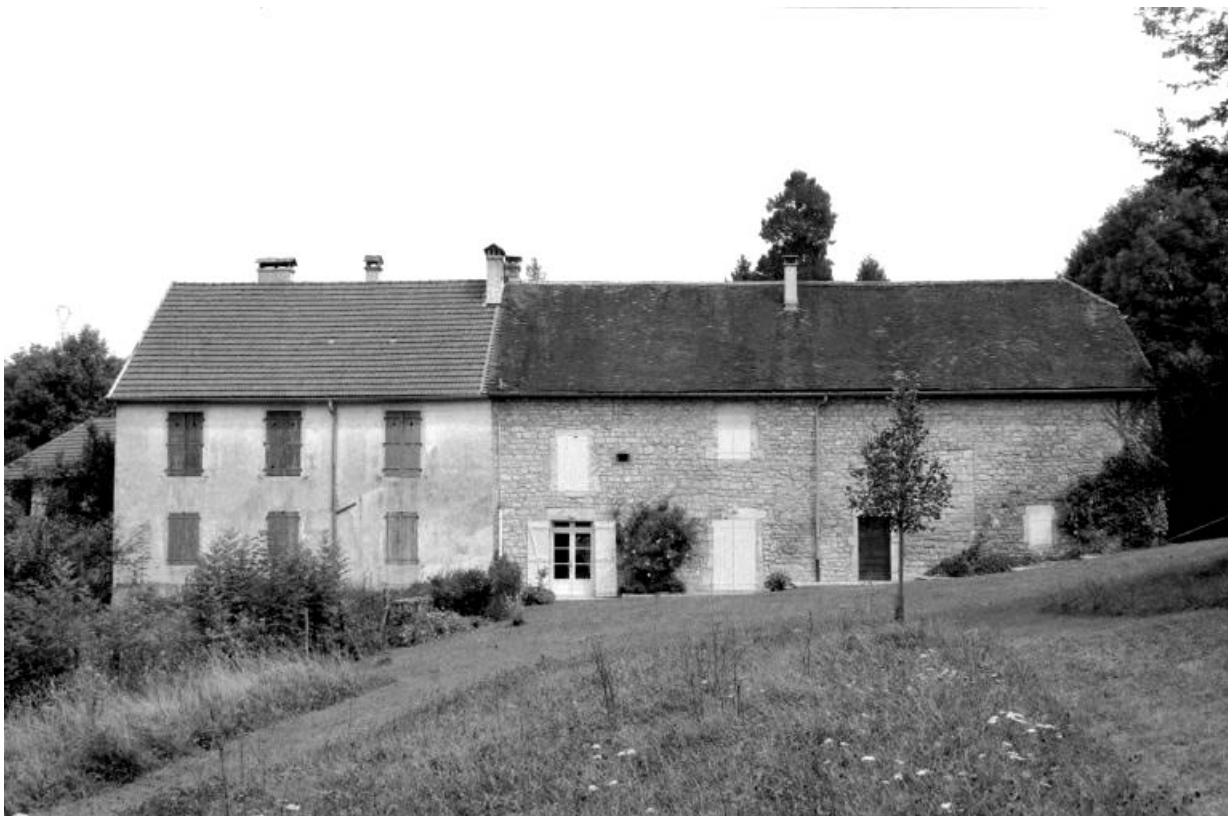
Façade antérieure du logement et de l'étable.
