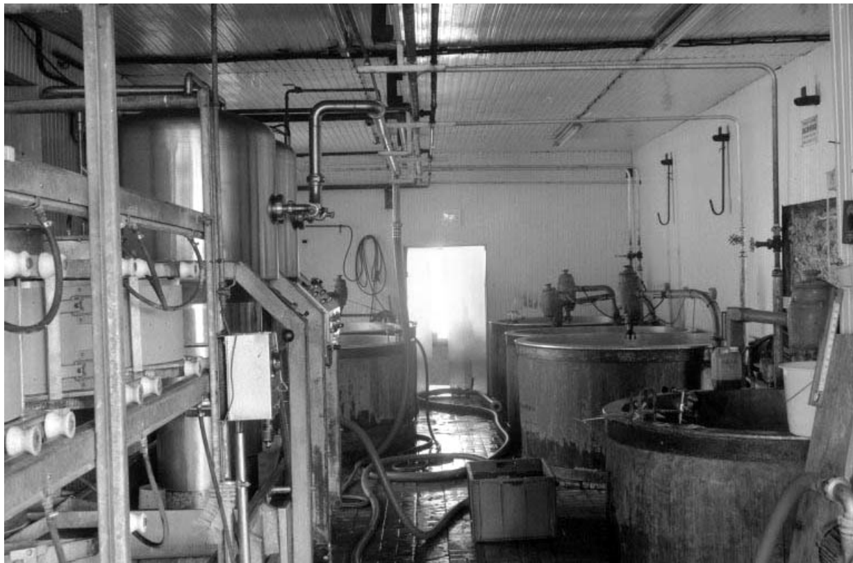
Intérieur de l'atelier de fabrication.
