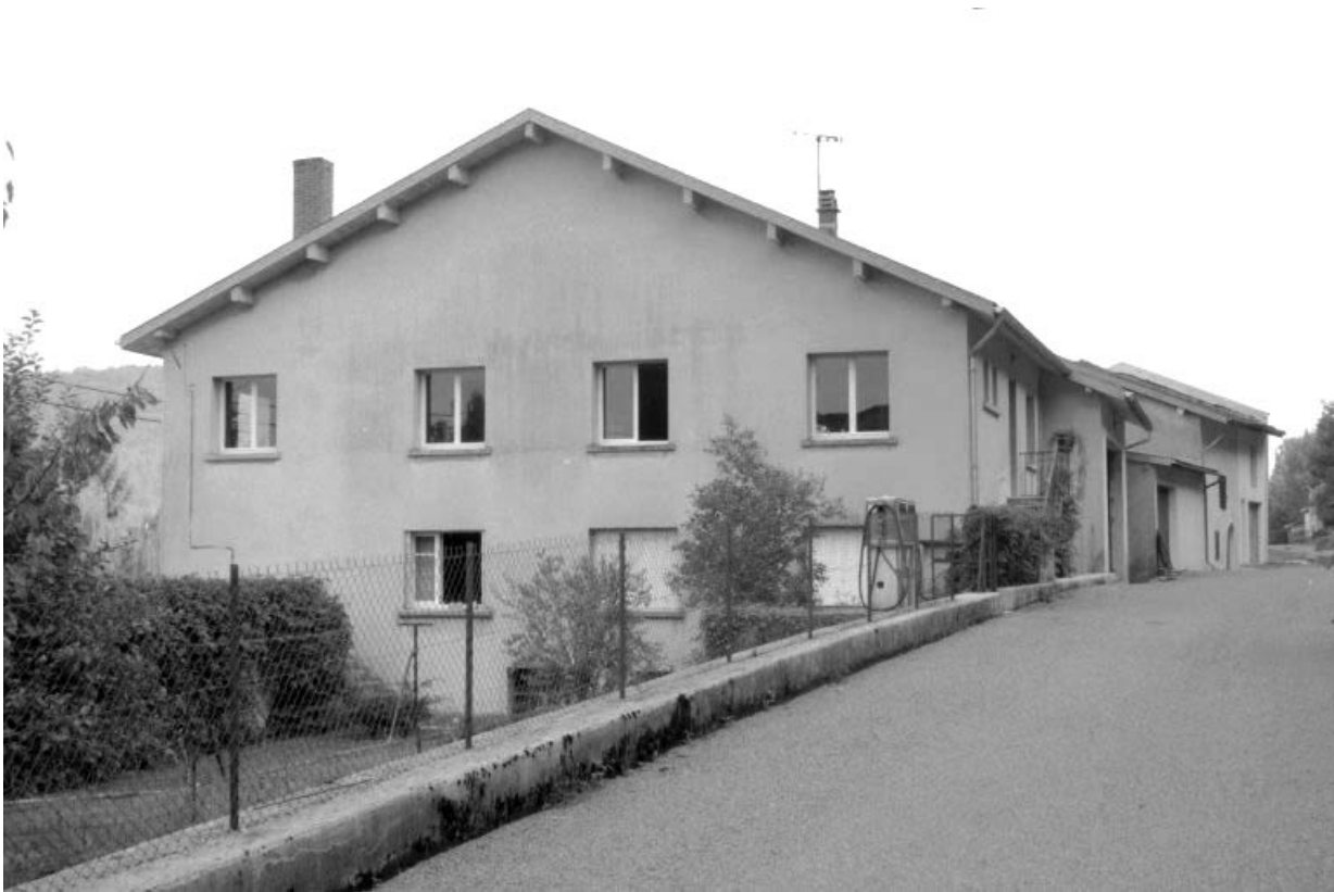
Façades latérale droite et postérieure.
