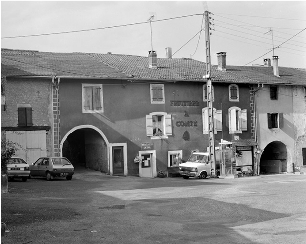
Vue d'ensemble de la façade antérieure. 39, Gigny
