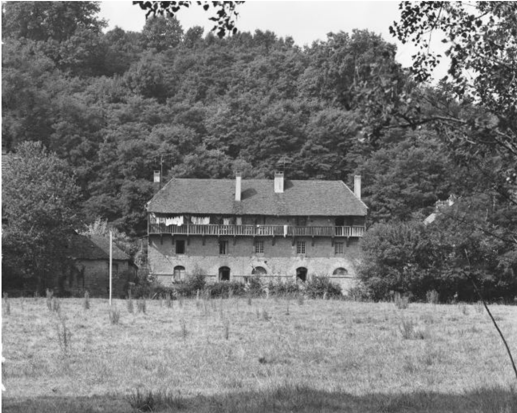
Façade postérieure d'un logement ouvrier.
