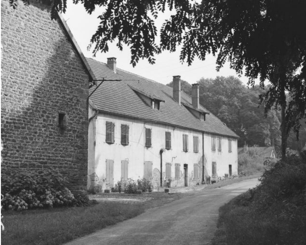
Logement patronal vu de trois quarts.
