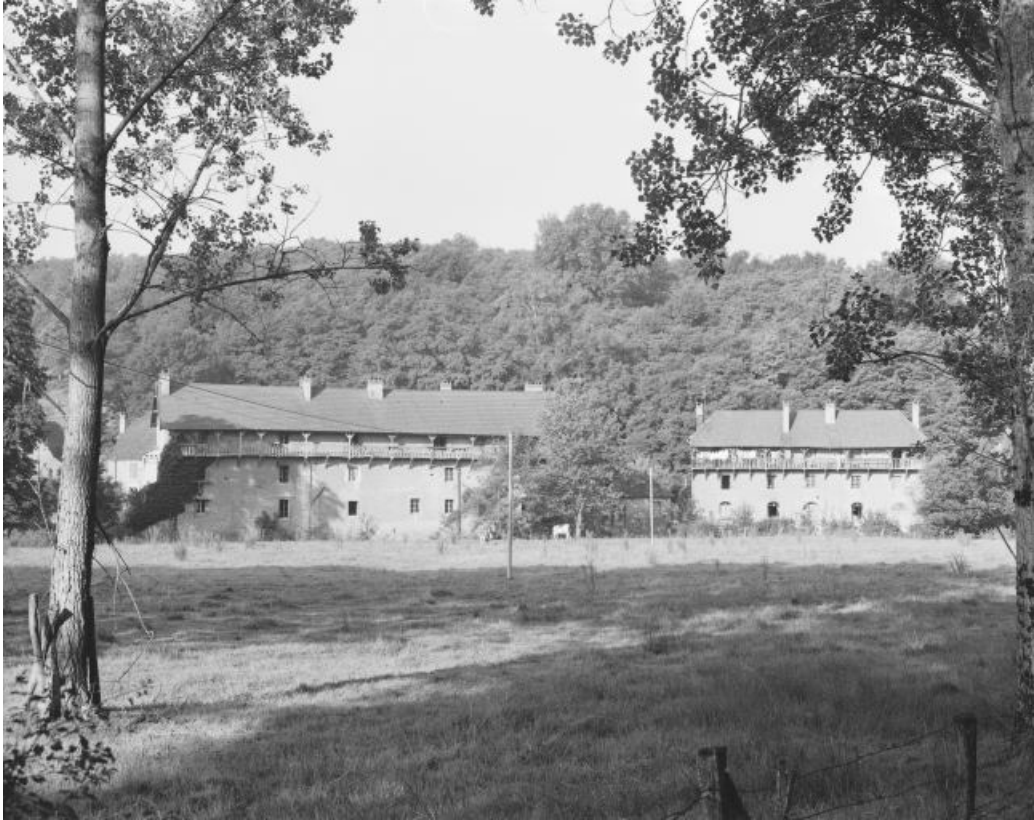
Façades postérieures des logements ouvriers.
