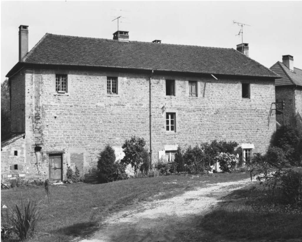
Façade antérieure d'un logement ouvrier.
