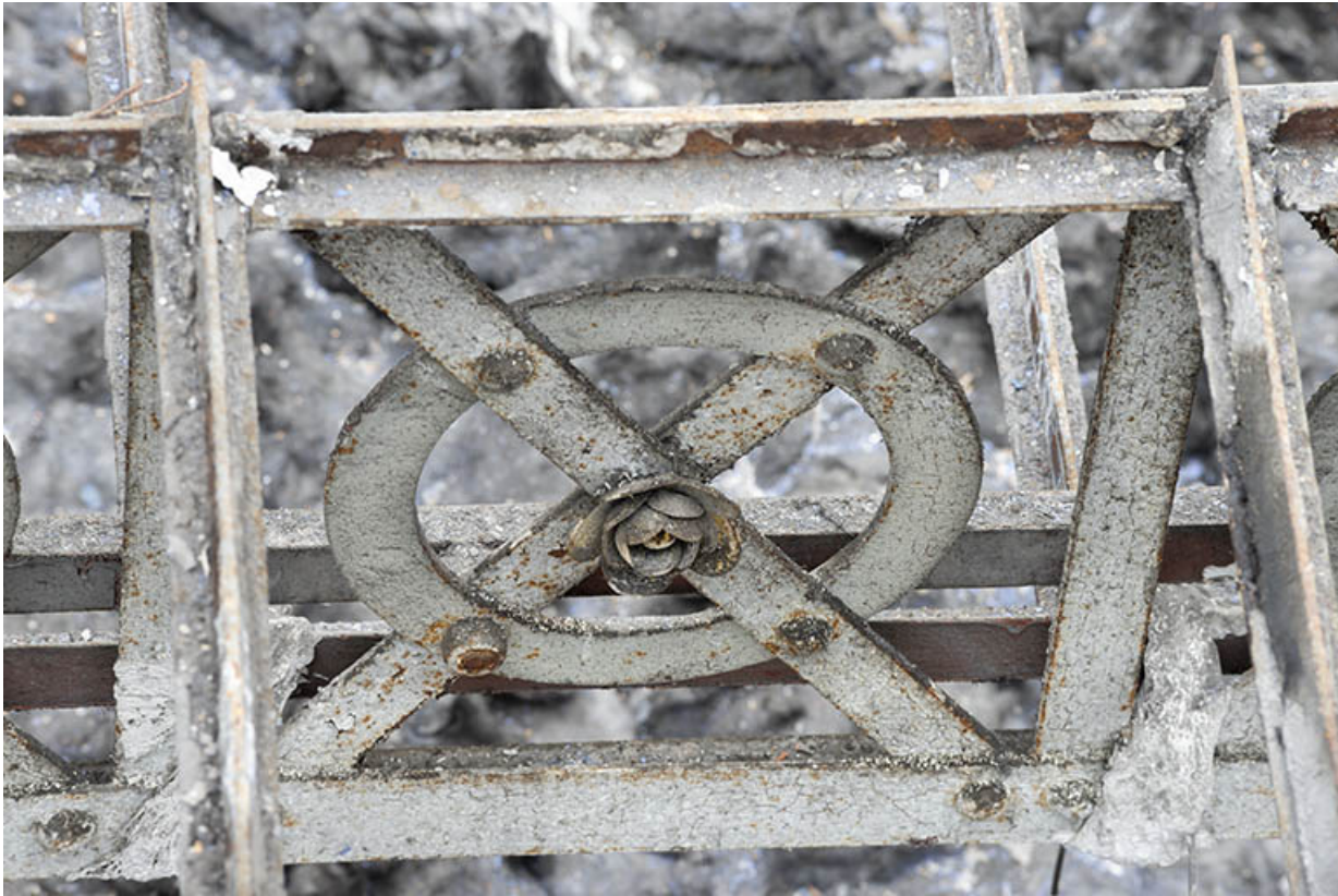
Halle : décor de la charpente métallique.
