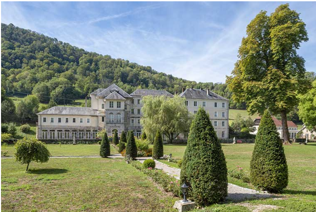
Façade principale, vue de trois quarts.
