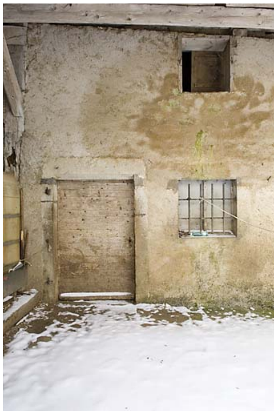
Façade postérieure : porte.
