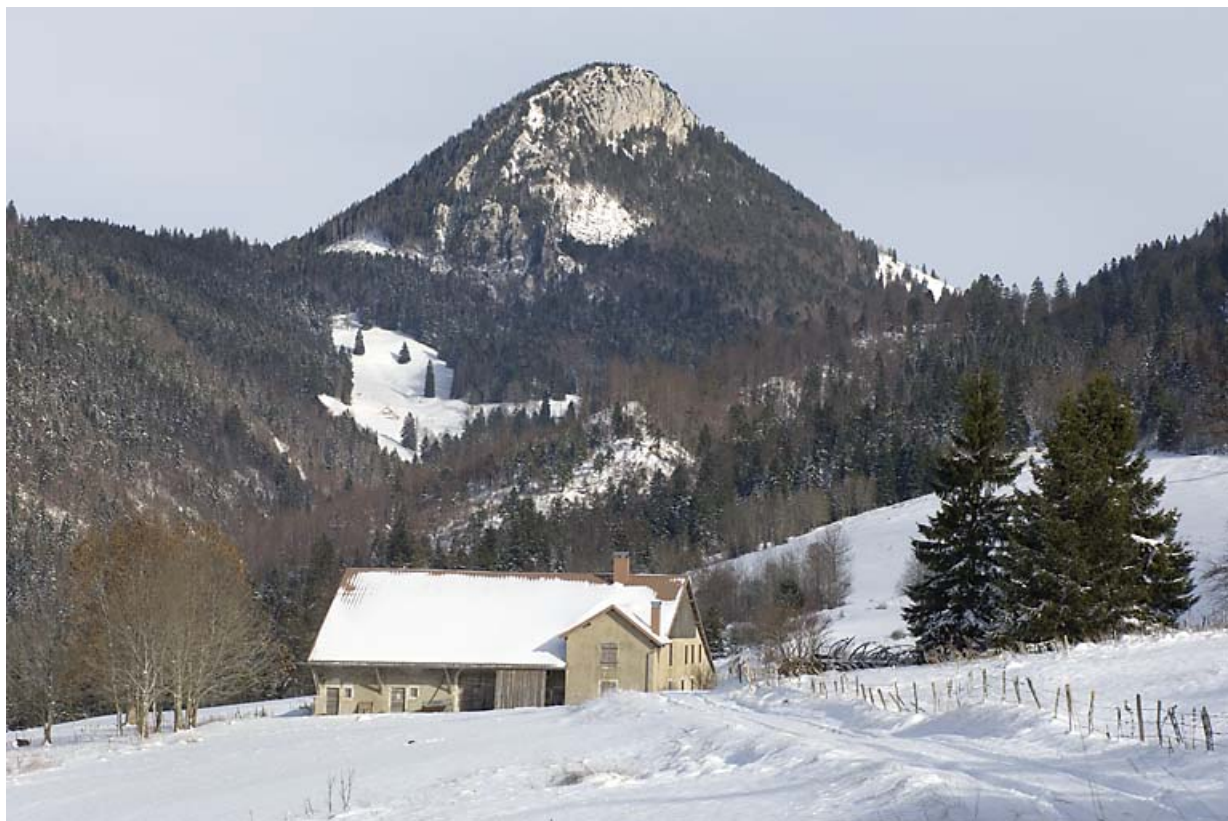
Vue d'ensemble depuis le sud-ouest, en hiver.
