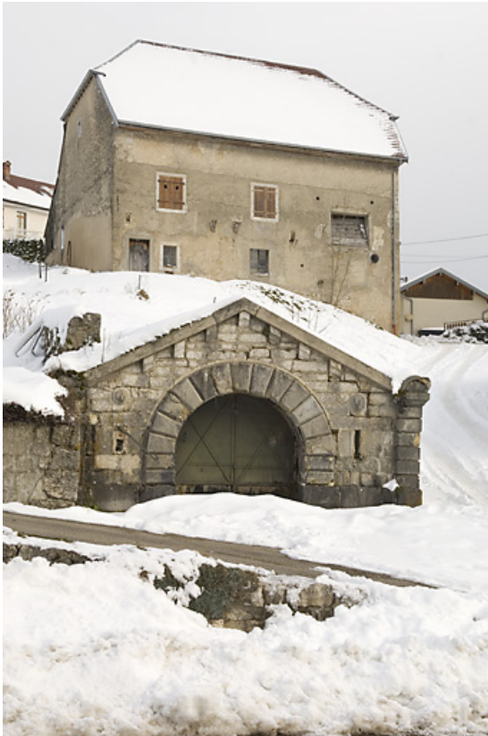
Réservoir des Portes, en hiver.
