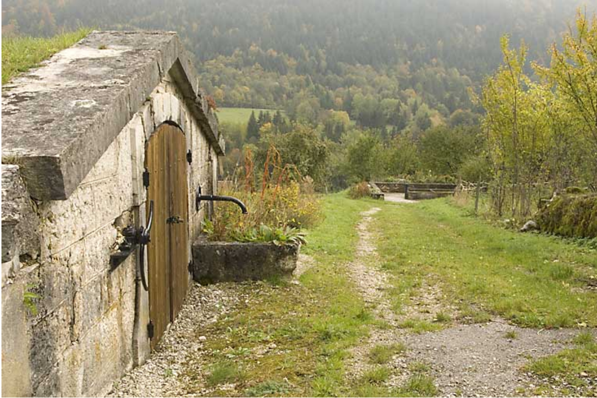
Réservoir des Maillots : façade vue en enfilade.
