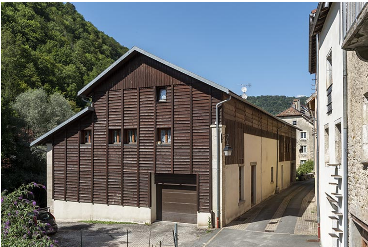
Tannerie : façades postérieure et latérale gauche.
