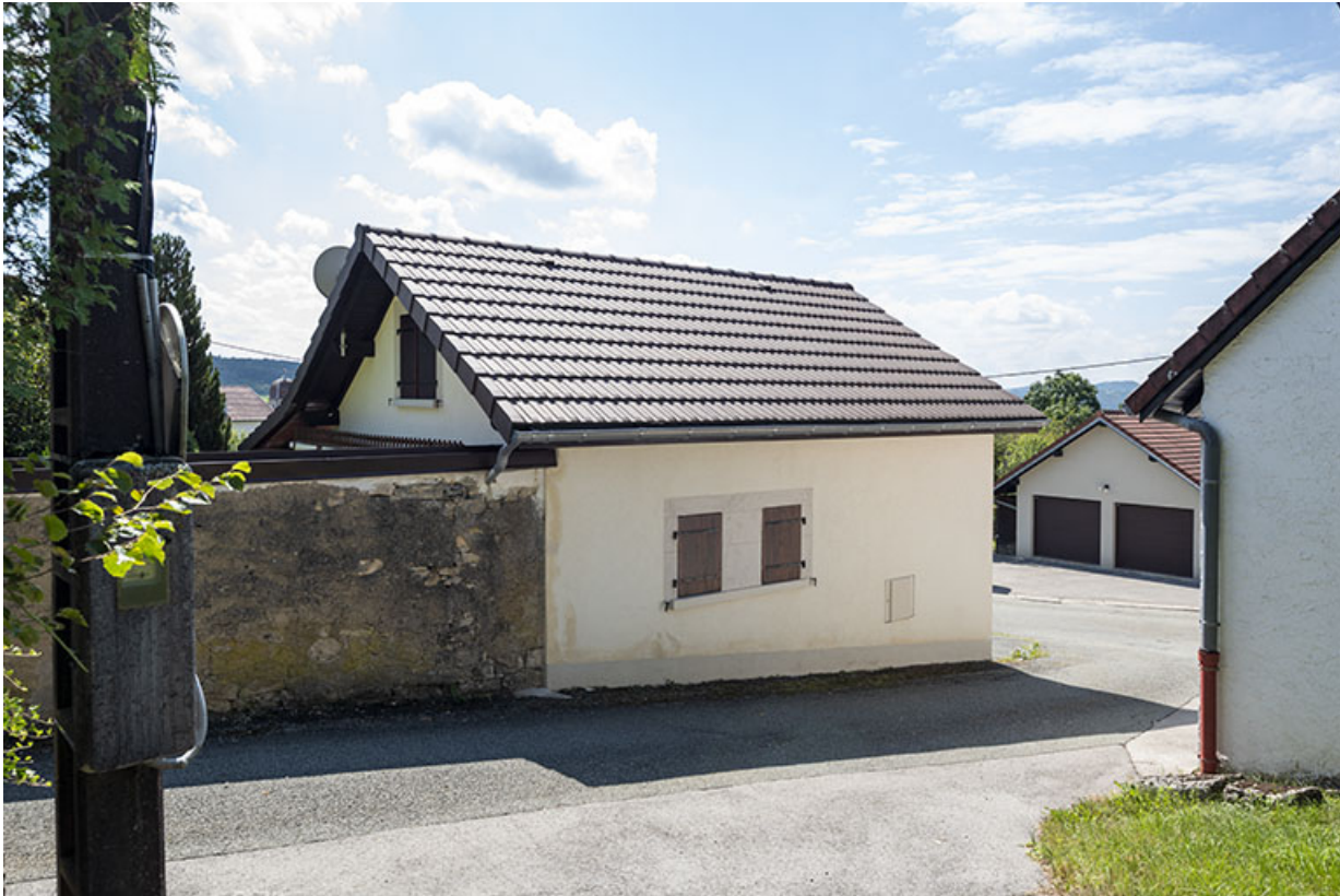
Nouvelle forge : façades postérieure et latérale gauche.
