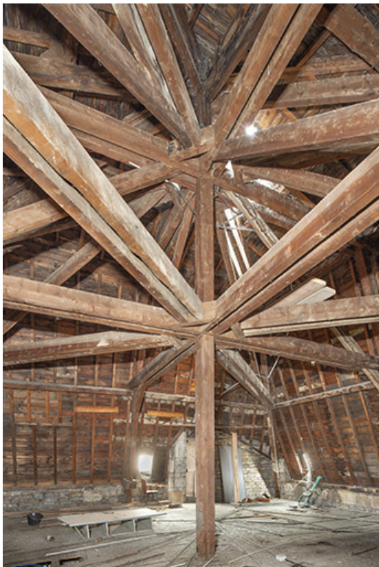
Charpente du pavillon ouest.
