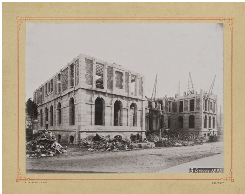
Chantier de construction (3 février 1893).
