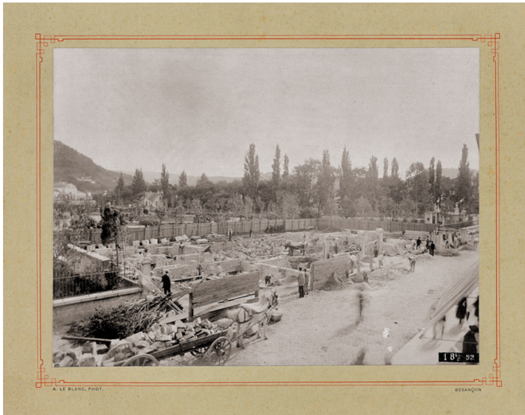
Chantier de construction (1er octobre 1892).
