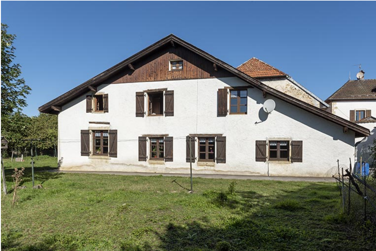
Maison au n° 47 : façade latérale gauche.
