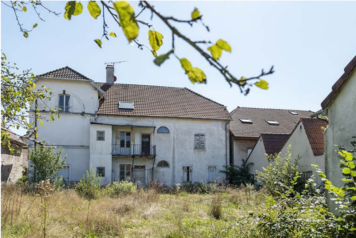
Logement : façade postérieure.
