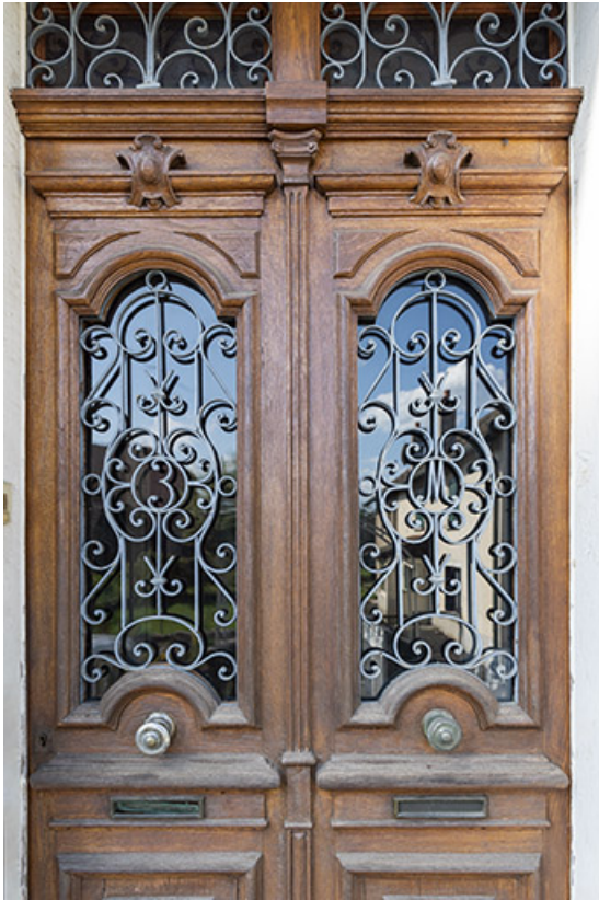
Logement : détail de la porte d'entrée.
