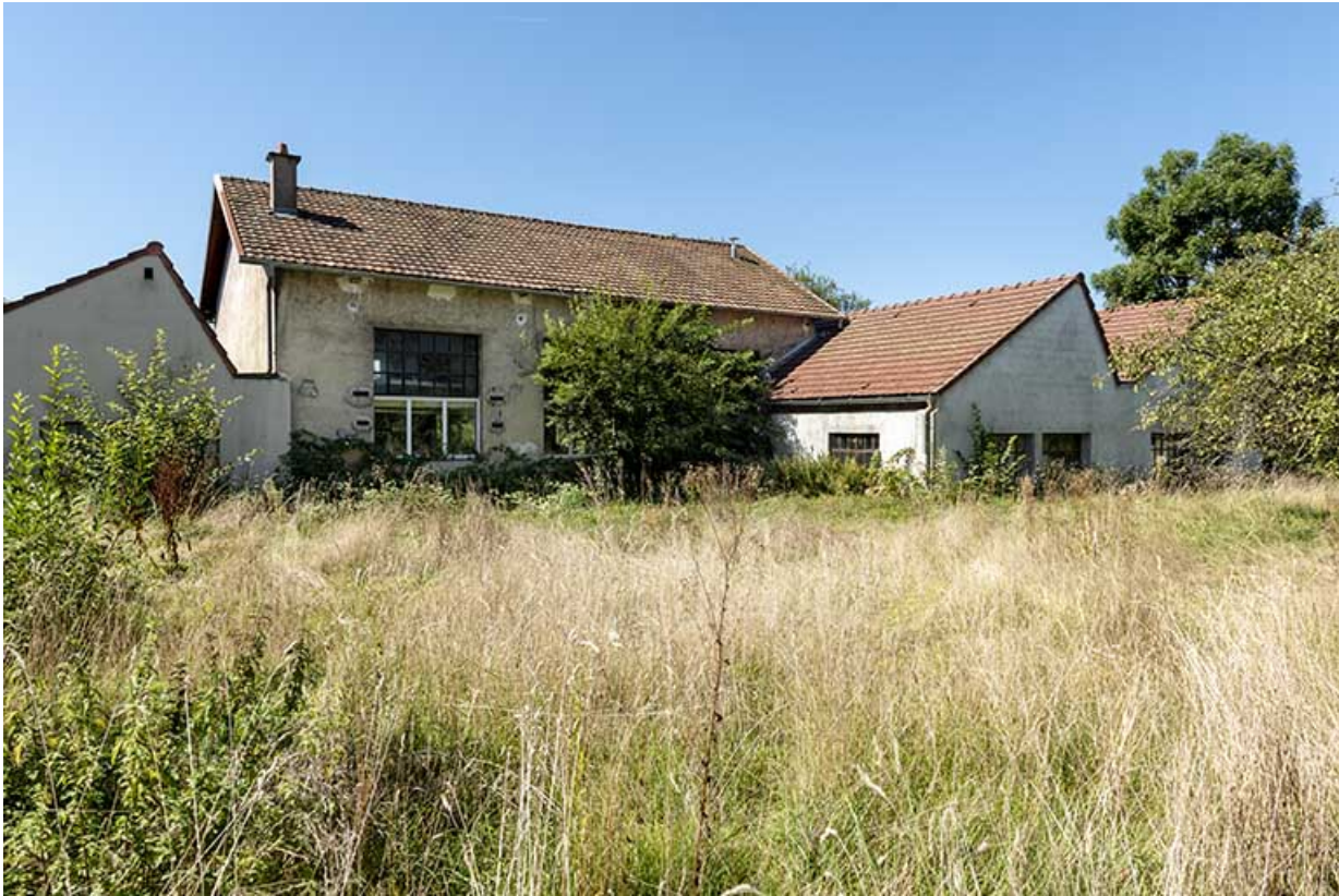
Usine : façade postérieure des ateliers (depuis l'est).
