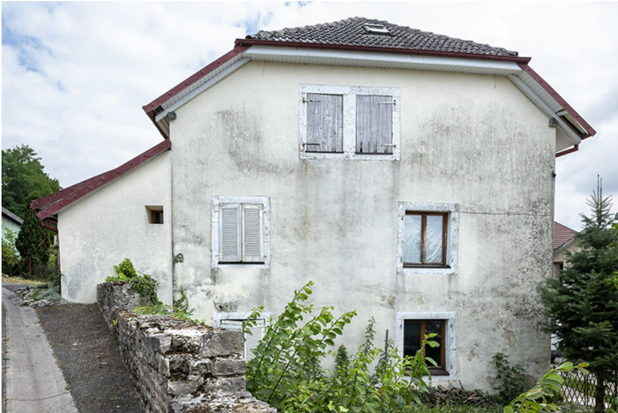
Bâtiment de 1723 : façade latérale gauche.
